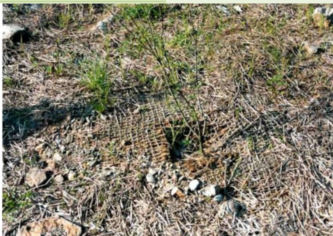
Stuoia in fibra di cocco Tresa - Canton Ticino, 2004
